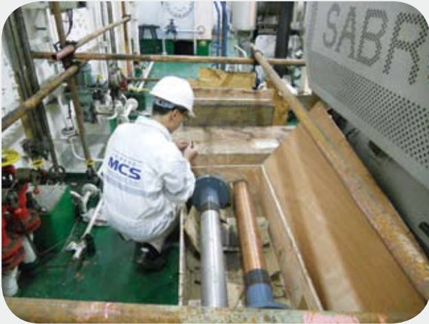
MGPS anode assembly
